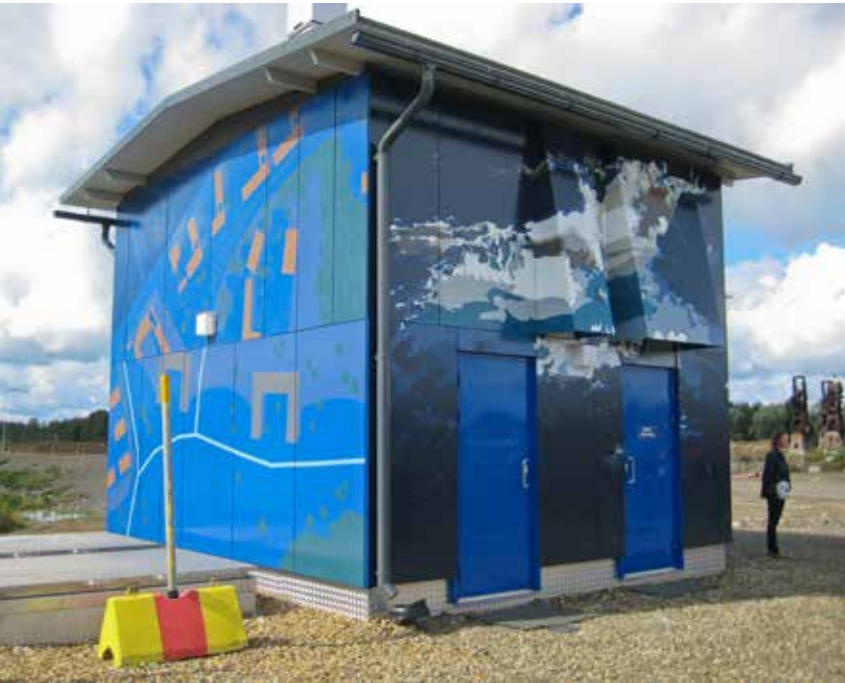
Suursahankadun jätevedenpumppaamo sai kauniin ulkokuoren.
